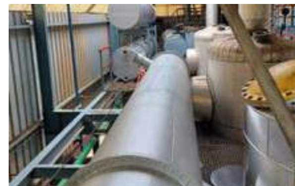
Imagen 2: Recepción de los equipos una vez reparados para proceder a su instalación en la extractora
