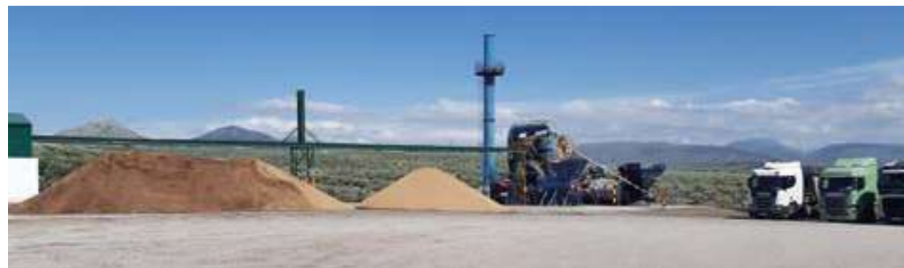
Instalaciones orujeras de Martos
