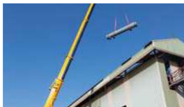
Imagen 1-2: Desplazamiento de equipos desde la extractora hasta el camión que debe transportarlos para su reparación
