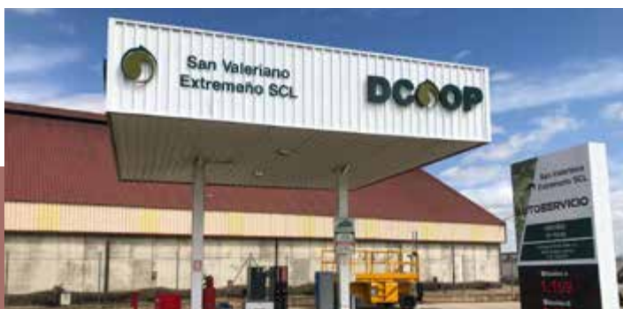
Marquesina de la gasolinera de la coopeativa de Gadiana (Badajoz)
